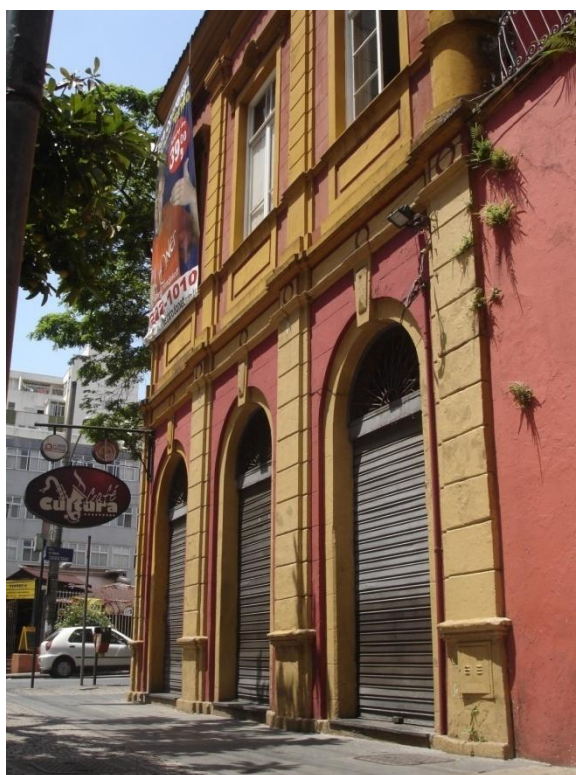
Rua dos Timbiras, número 1605, esquina com Rua da Bahia. Construída em 1904. Atualmente funcionam O Núcleo de Estudos Teatrais e o Café Cultura
